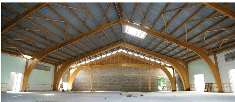
LE NOUVEAU HALL D'ENTREE COTE NORD
