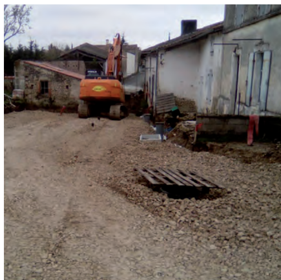
tranchée commune au niveau du lot 10
