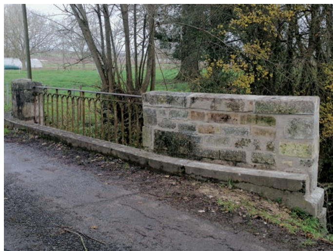
Le pont de Malveau Le pont de Marnay
