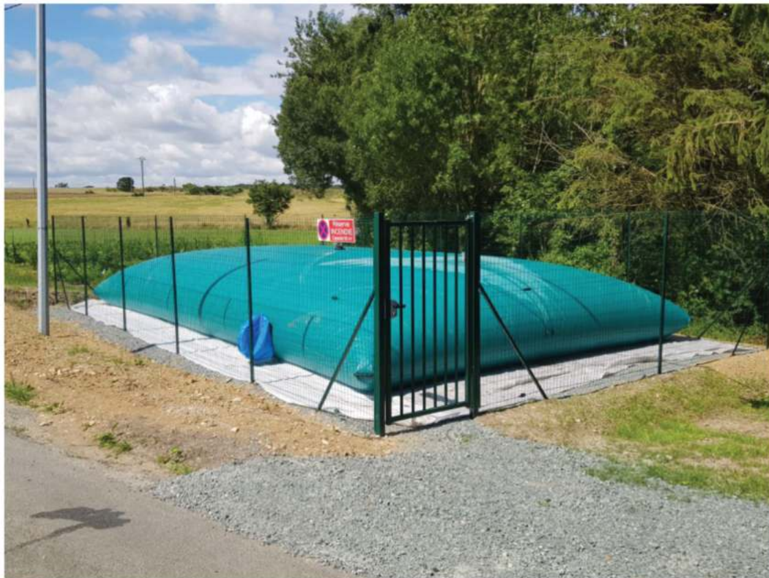
Bâche à incendie installée à Marnay. Photo DR
