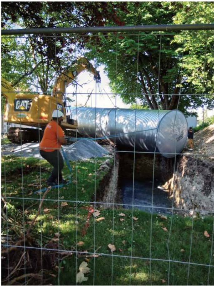
Positionnement de la cuve dans la fosse. Photo DR
