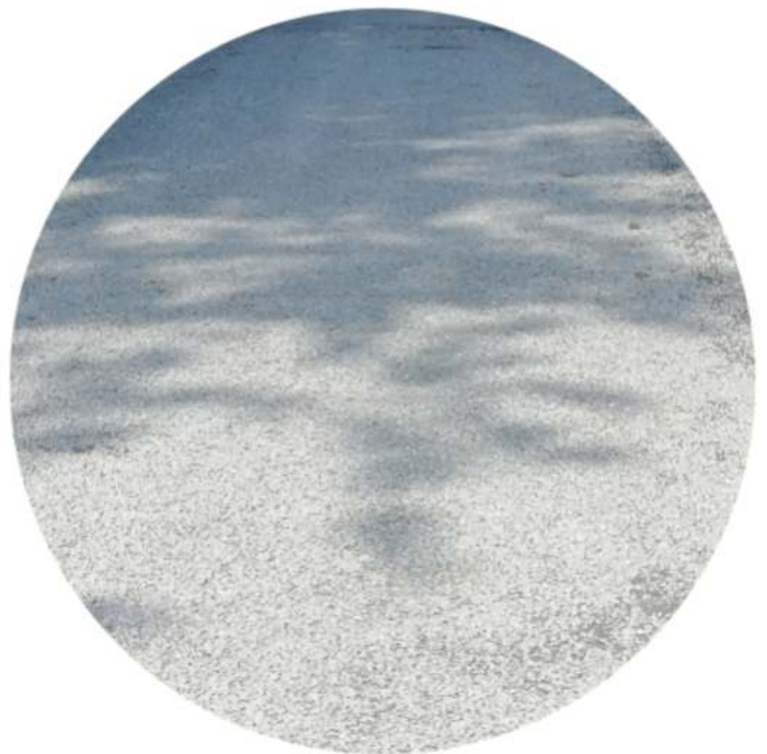
Détail du revêtement . Photo: B.Dupeu
